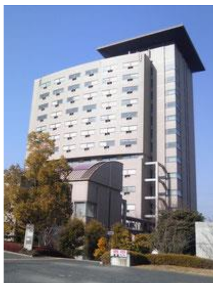
写真1 けいはんなプラザ ラボ棟 (出典：組合ホームページ)
